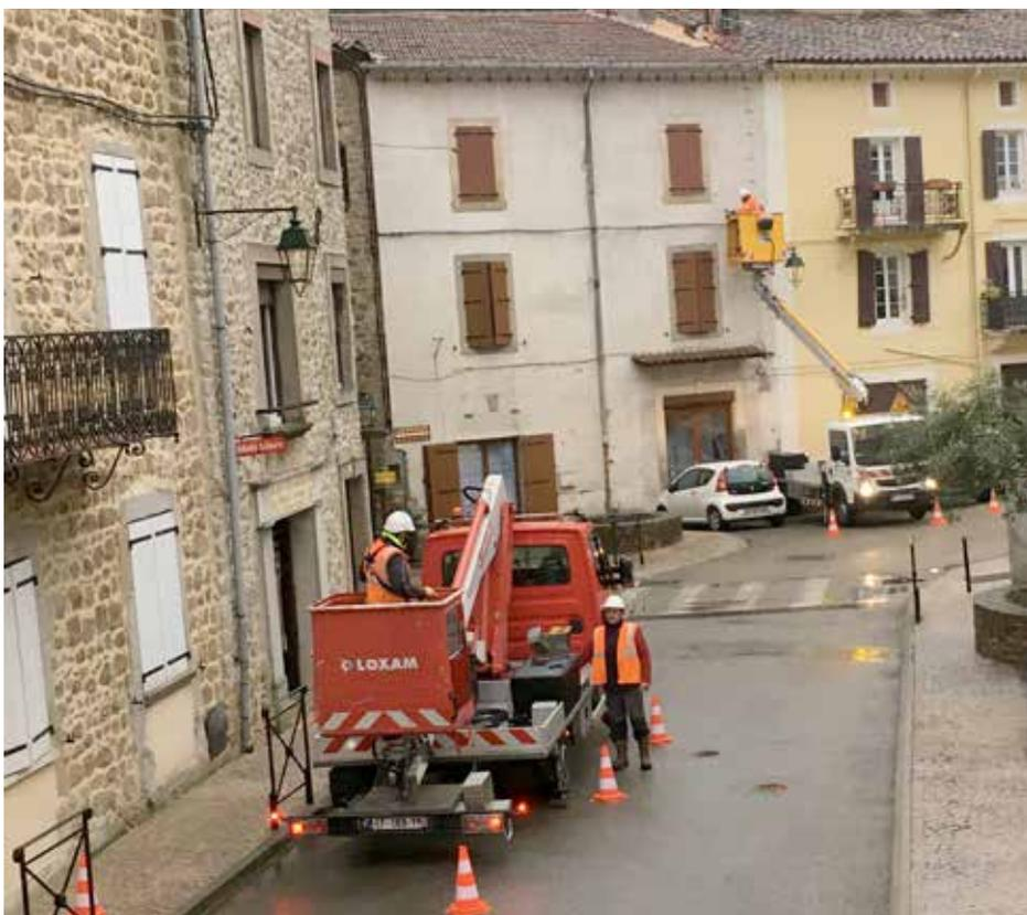
Financés par le SMEG (Syndicat Mixte d'Électrification du Gard) les travaux de mise en discrétion des câbles électriques se poursuivent Place Pierre Agniel. L'entreprise SPIE a procédé à la mise en place des nouveaux câbles sous les génoises. Il ne reste plus qu'à effectuer le raccordement au réseau une fois qu'ENEDIS aura donné son feu vert et ensuite à déposer les anciens câbles.
